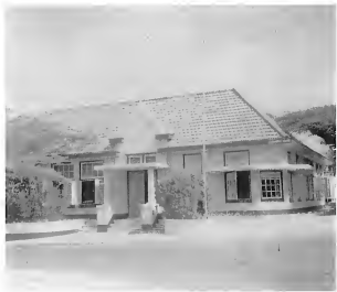
Het gebouw van de bibliotheek aan de Lagoenweg 11. Bron: Fotocollectie Arabiana/Caribiana, BNA
